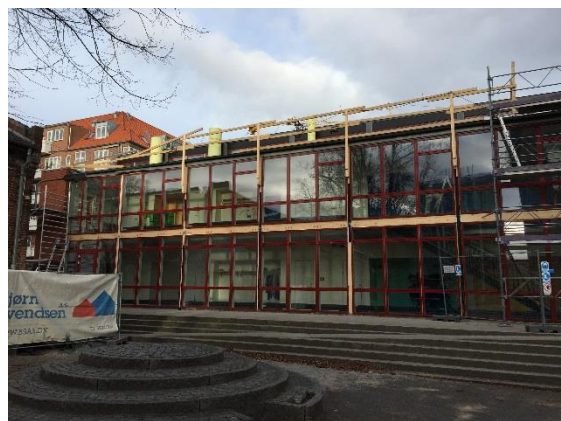
Strandvejens skole: Vinduesudskiftning i facade og i klasserum med automatisk vinduesåbning, dørudskiftning og facademodernisering
