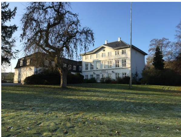
Nærumgård: 4 delopgaver: Renovering af gesims m.m., tagrenovering, vinduesrenovering og asfaltbelægning
